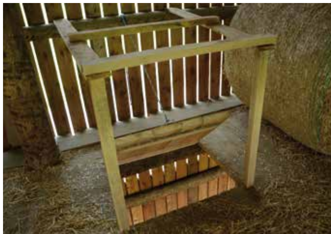
Abbildung 18: Abwurfkufen sind mit Absturzsicherungen zu versehen. (© Susanne Schönhart)
