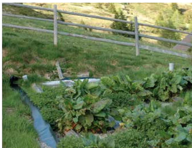
Abbildung 8: Pflanzenkläranlage auf der Alm (© Susanne Schönhart)
