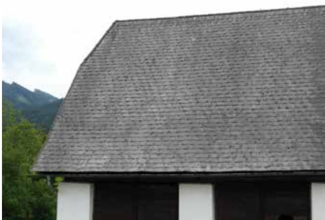
Abbildung 28 Bei alten Stalldächern wurden häufig Dachschindeln aus Asbestzement verwendet. (© Susanne Schönhart)
