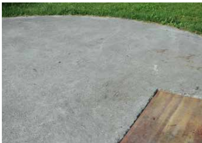
Abbildung 21: Deckel geschlossener Güllegruben müssen eine entsprechende Tragkraft aufweisen. (© Susanne Schönhart)
